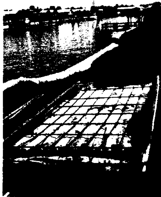
Fig. 20. Replacement slab
