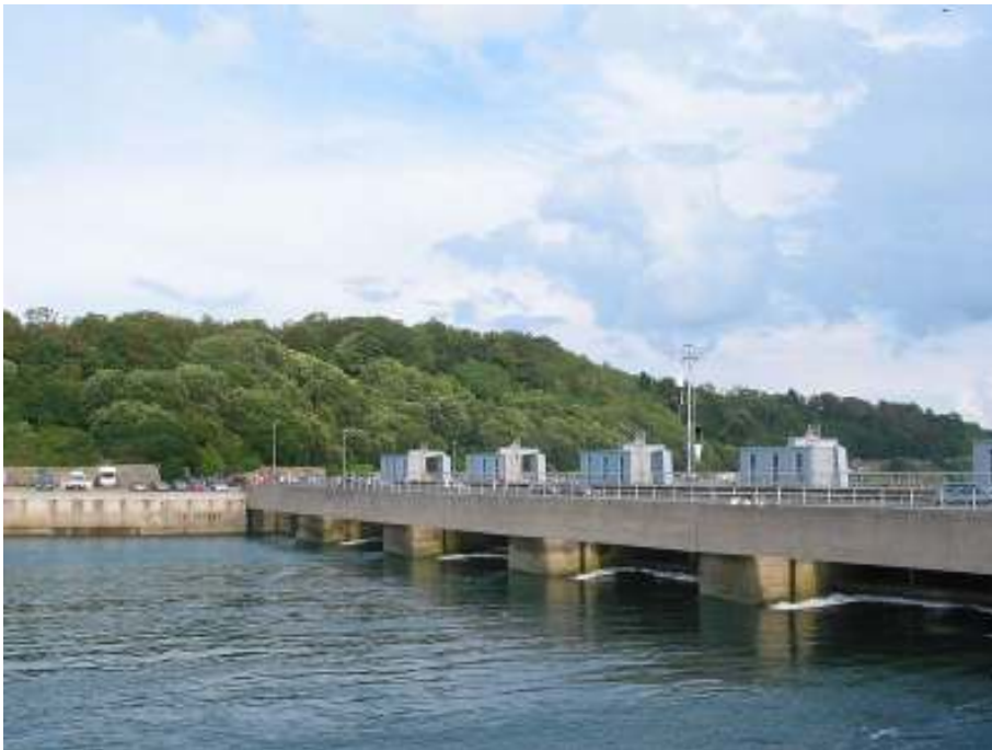
Figure 1 : La Rance Tidal Barrage
